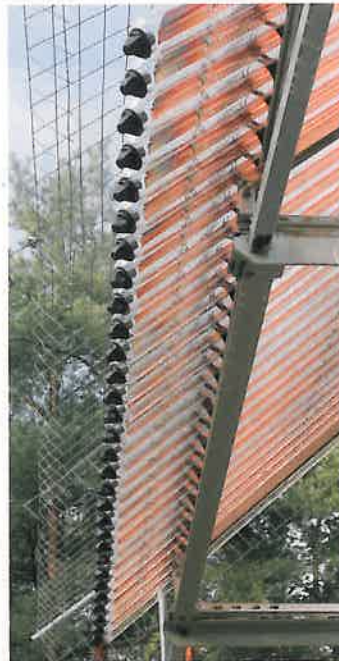
Ein stabiler Drahtkäfig schützt die leistungsfähigen Vakuumröhren, in denen das Duschwasser des SV Erlenbach von der Kraft der Sonne erwärmt wird
