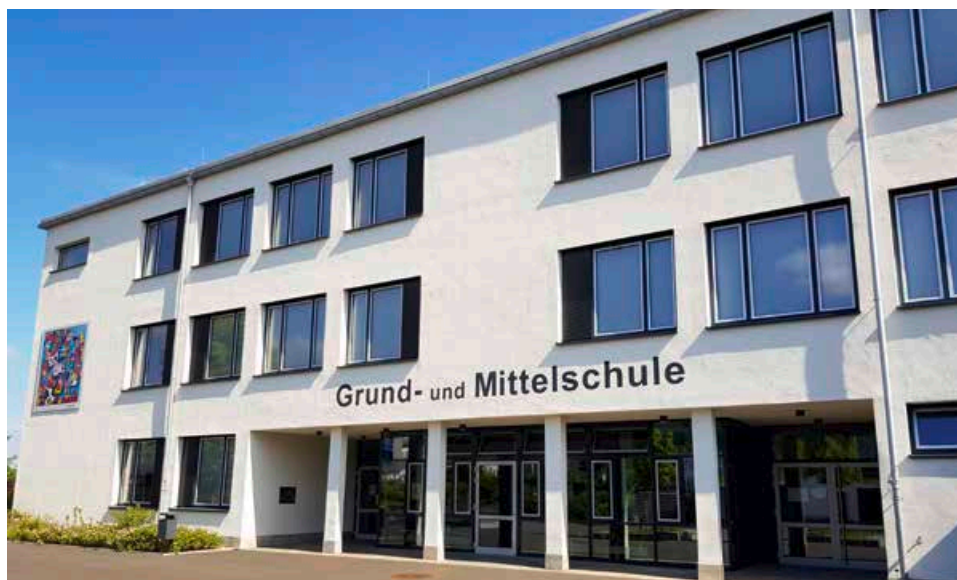
Die Grund- und Mittelschule in Wörth verfügt – wie alle anderen Schulen im Mainbogen – seit Anfang des Schuljahrs über einen schnellen Glasfaseranschluss. Eine Point-to-Point-Verbindung sorgt dafür, dass sich die Schule die Bandbreite mit niemandem teilen muss.
