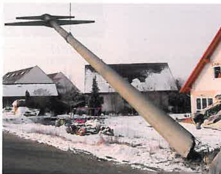
Freileitungsmaste werden abgebaut
