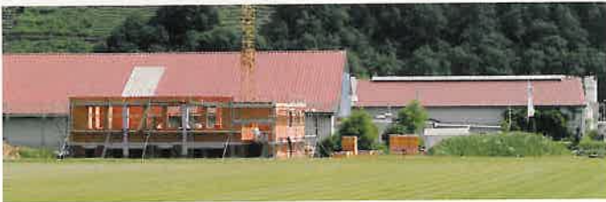
Auf dem Dach des Mehrzweckgebäudes soll ein Sonnenkraftwerk Strom erzeugen
