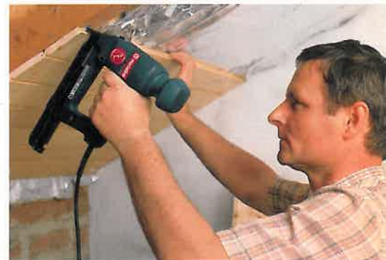
Die Energieeinsparverordnung verlangt das Dämmen von Dachgeschossdecken
