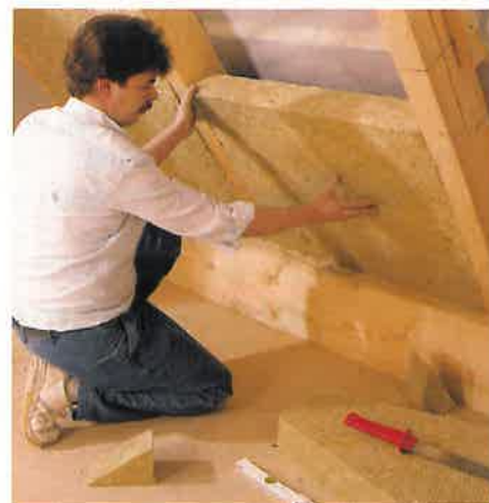
Exaktes Arbeiten ist beim Dämmen wichtig
