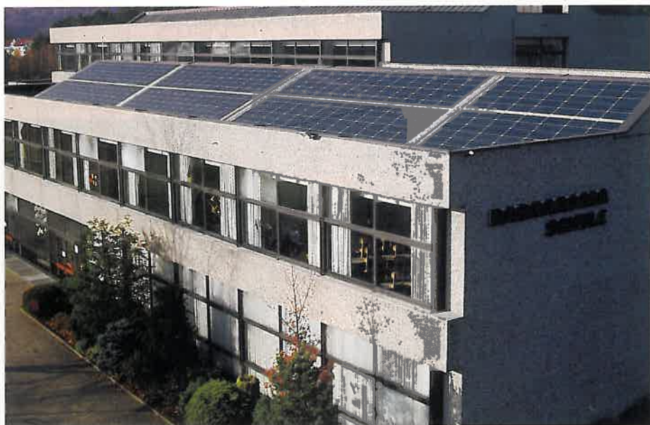
Für eine weitere Photovoltaikanlage stellt die Stadt Erlenbach unentgeltlich das Dach der Barbarossa-Schule zur Verfügung. Auch hier können sich Bürger beteiligen
