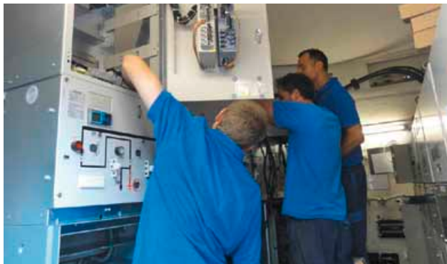
Eingespieltes Teamwork: Karlheinz Scherf (rechts), Stefan Daniel und Waldemar Bartel schließen eine neue Mittelspannungs-Schaltanlage in einer Ortsnetzstation an.
