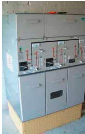
Bei der Modernisierung erhalten die Ortsnetzstationen jeweils eine neue Mittelspannungs-Schaltanlage, ...
