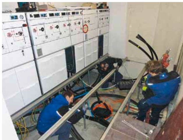
Arbeit im Untergrund: Anschluss der 20.000-Volt-Kabel an der neuen Mittelspannungs-Schaltanlage. Die Kabel sind später nicht mehr zu sehen. Viele Ortsnetzstationen verfügen wie diese über einen doppelten Boden. Dieser Aufbau macht die Installation zwar etwas komplizierter, bringt aber im laufenden Betrieb zahlreiche Vorteile.
